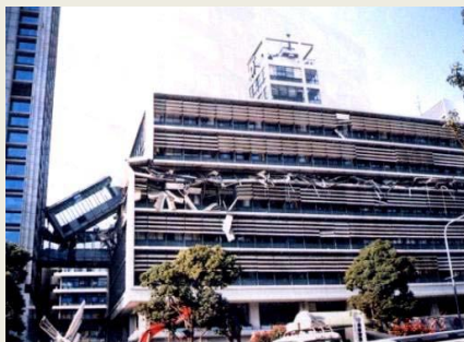
تصویر ۳- ژاپن، کوبه: مقایسه آسیب وارد شده به ساختمانهای روزمینی و زیرزمینی در زمین‌لرزه سال ۱۹۹۵ منبع: Godard, 2004
